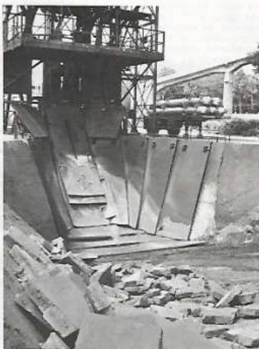
Le carneau du point fixe n° 2, après un essai très « poussé » du moteur Valois.
