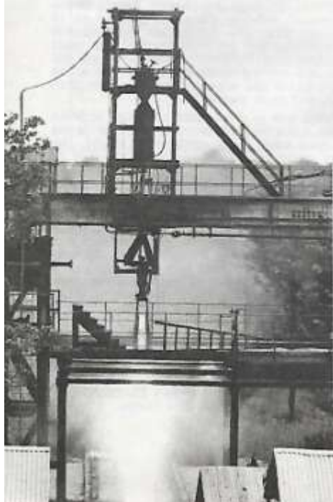
Point fixe n° 1 (1953). Le moteur essayé est l'un des premiers moteurs de Véronique.
