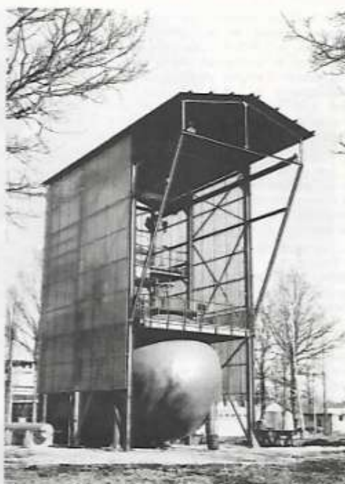
Point fixe n° 7. Pour essai de démarrage de moteur sous vide.
